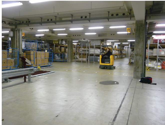
Abbildung 6. Rippendecke mit Staplerverkehr
