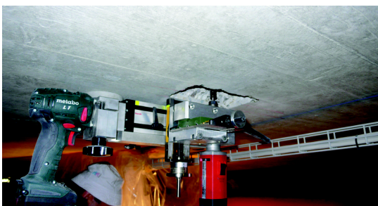
Abbildung 3 Baustellenfräseinrichtung zur Herstellung der Koppelfläche
