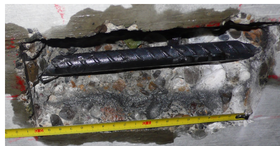
Abbildung 4 Freigelegter Bewehrungsstahl mit Koppelfläche
